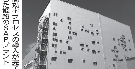
高効率プロセスの導入が完了した姫路のSAPプラント
