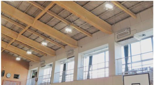
体育館2階のギャラリー上部に設置した室内機。送風口上部に取り付けたエア搬送ファンで効率よく風を送り込む
