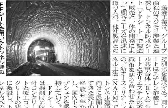
藤森工業は、グループ各社のフジモリ産業と連携し、トンネル防水シート「Fシート」を開発した。従来の防水シートに比べて、施工性が向上し、コスト削減が期待される。また、防水性能も向上し、トンネルの耐久性が向上している。このシートは、トンネルの内壁に貼付され、雨水の浸入を防ぐ。また、トンネルの内壁を保護し、劣化を防ぐ効果もある。
