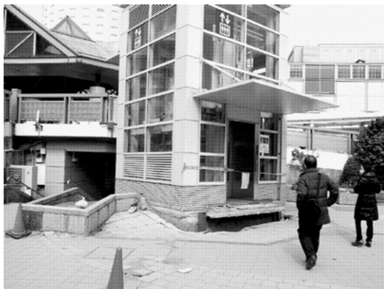
千葉 新浦安駅前JR京葉線のエレベーター、液化化被害が大きく使用できない(3月30日)
